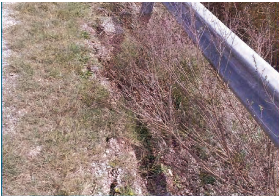
Longitudinal crack displaces guardrail
