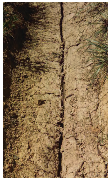
Longitudinal crack
